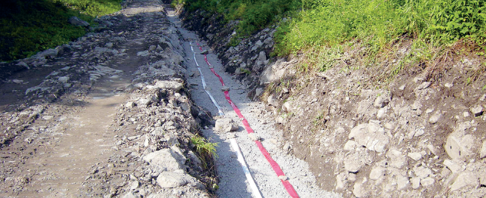
Betonrohrblock einer Erdkabelleitung mit aufgelegten Warmbändern.
